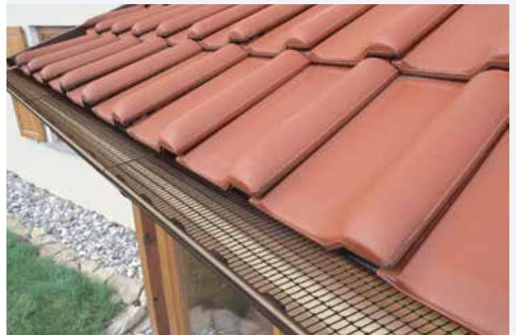
Fertig montiert ein nahezu unsichtbarer Schutz gegen Verschmutzen und Verstopfen durch Laub.
